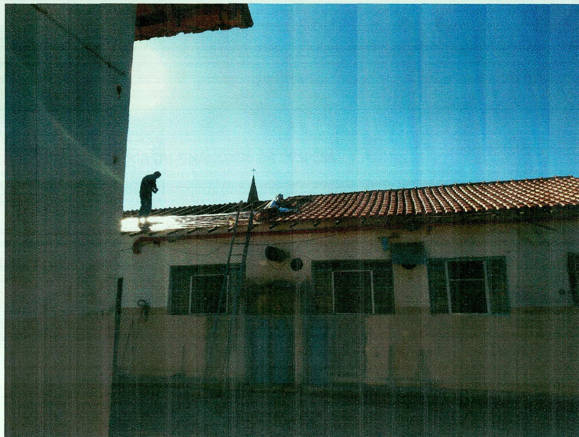
REFORMA DO TELHADO
